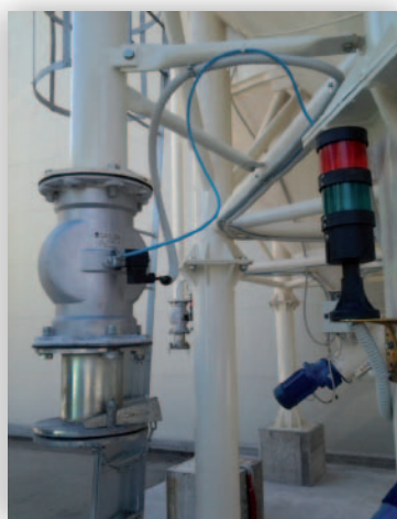
Controllo pressione al carico silos cemento.
